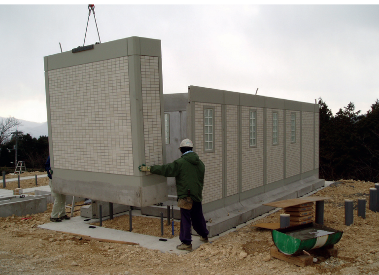
Рис. 2 и 3: Сборка бетонных элементов на стройке
